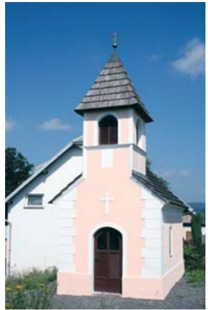
Nákladem padesáti dvou tisíc korun byla místními podnikateli opravena kaplička v Mezirolí. Jednalo se o generální opravu vchodových dveří, opravu fasády včetně nových barev a opravu klempířských prvků.
