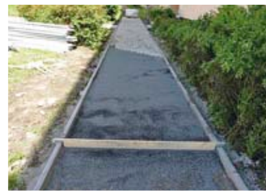
3. Sídliště Pod Nádražím - oprava chodníku
