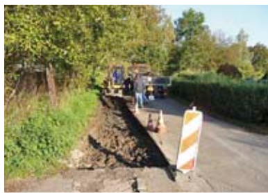
2. Úprava krajnice komunikace na Bouchalku
