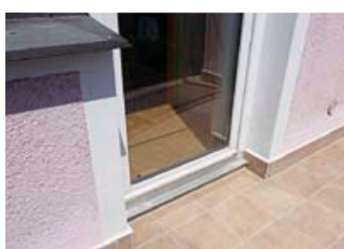
5. Nádražní čp. 291 - oprava balkonů
