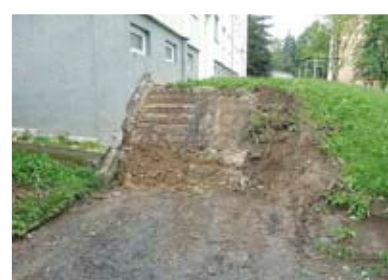
6. Školní čp. 65 - odstranění schodiště
