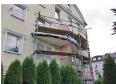
4. Nádražní čp. 288 - oprava balkonů
