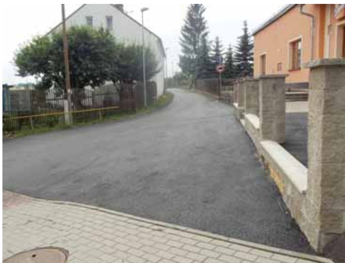
Pohled na opravené komunikace v Jimlíkově.
