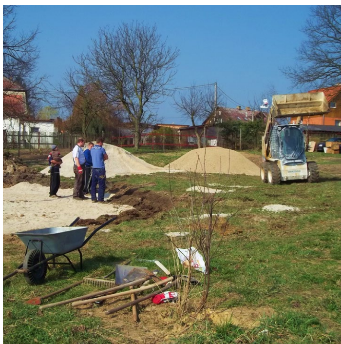
Společná výstavba hřiště, rok 2015
