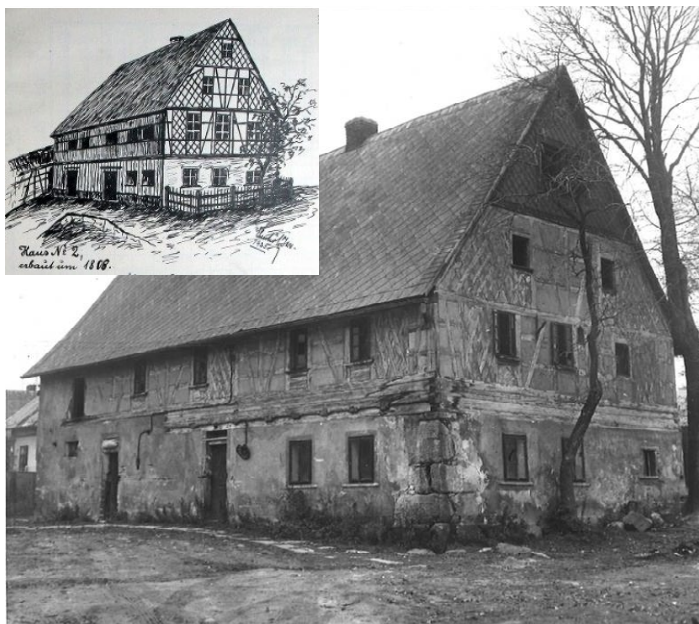
Bývalý dům čp. 2
